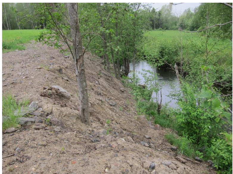
Jordschaktningsarbete nära ån kan öka erosionen om vallen görs brantare än tidigare. Foto: Aurelia Mäkynen
